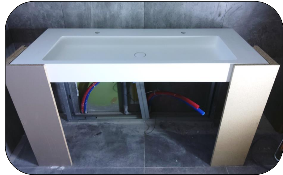
Vasque posée avec deux pieds provisoires
