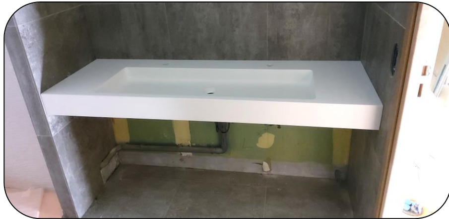
Vasque entre mur posée
